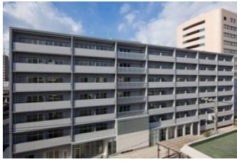
(レジデントハウス外観)
