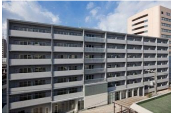
(レジデントハウス外観)
