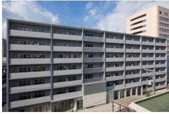
(レジデントハウス外観)
