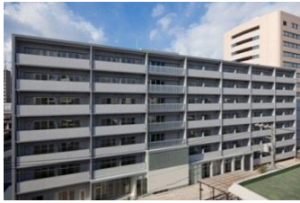
(レジデントハウス外観)
